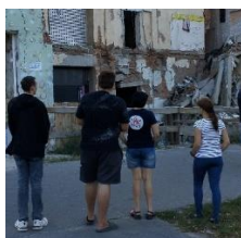
Рис. 2 – зруйновані будівлі в м. Охтирка
