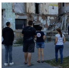
Рис. 2 – зруйновані будівлі в м. Охтирка
